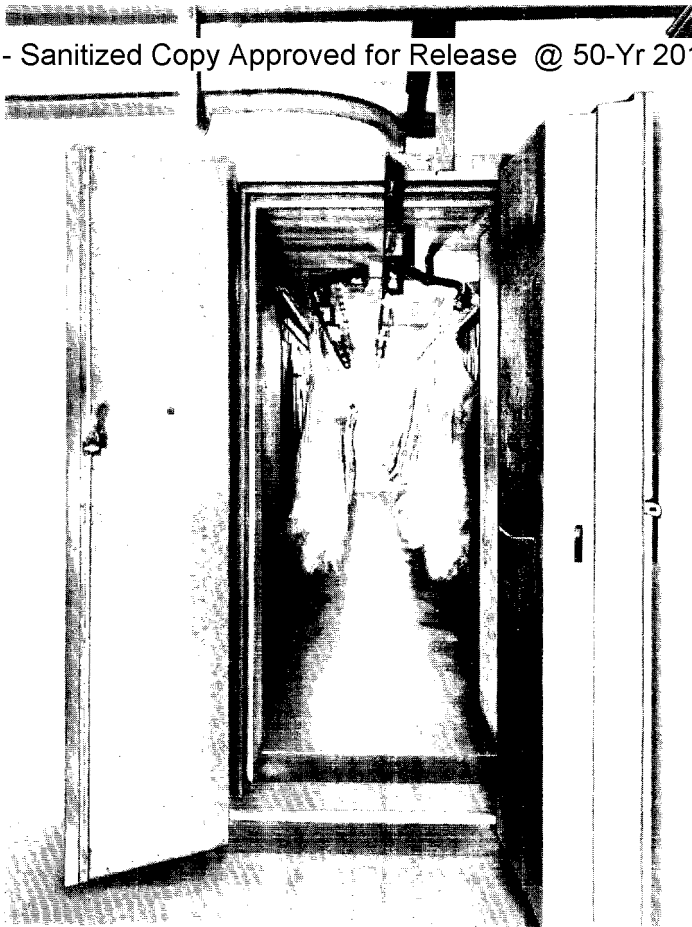
Fleischtunnel im Kühlhaus Eiswerder, Berlin (Baujahr 1952)
