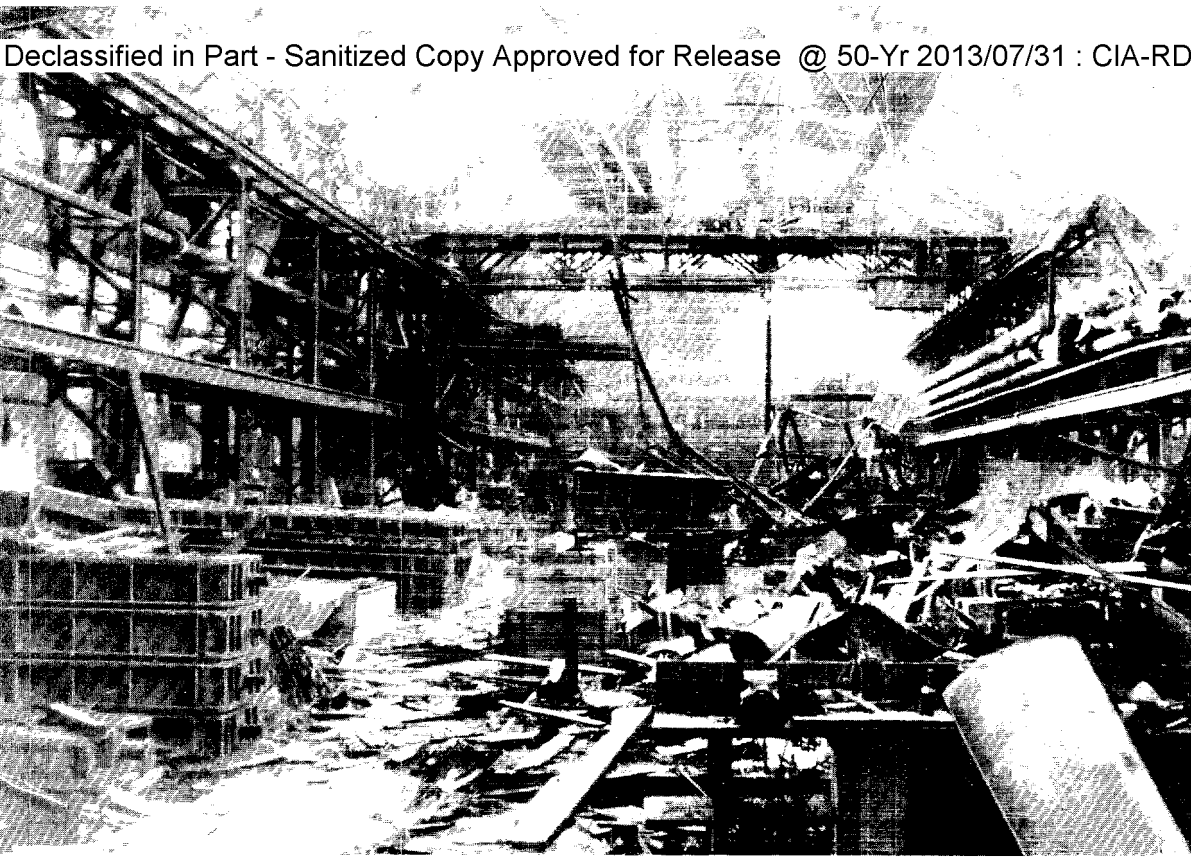
Die zerstörte Gießerei
