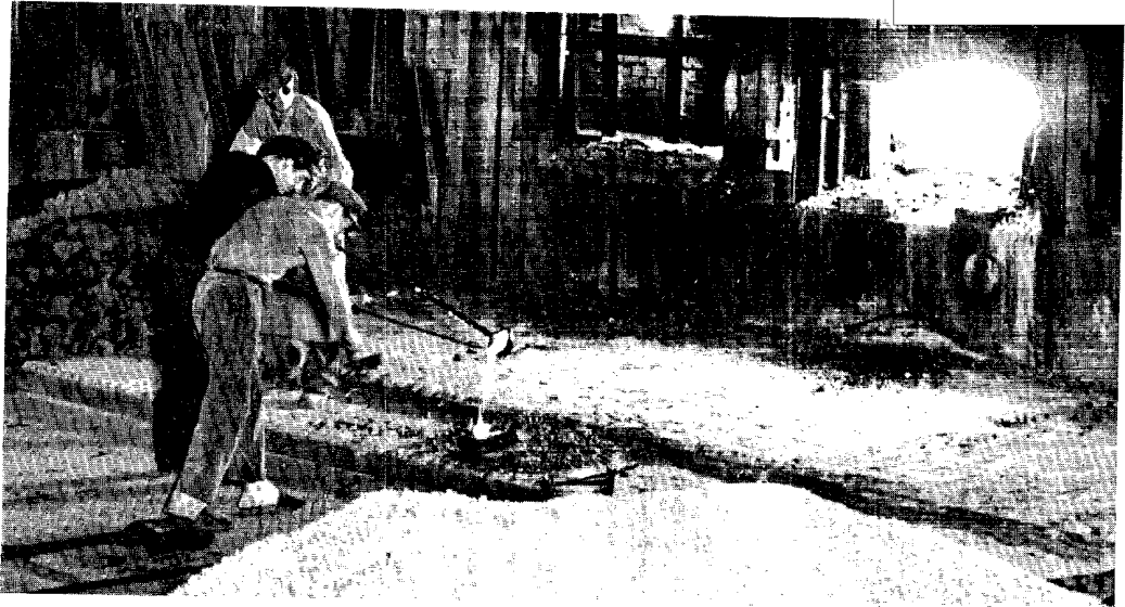
Abnahme einer Probe auf der Ofenbühne im Stahlwerk
