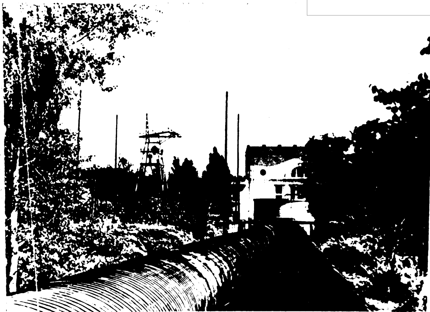
Напорный деревянный трубопровод Корсунь-Шевченковской гидроэлектростанции
