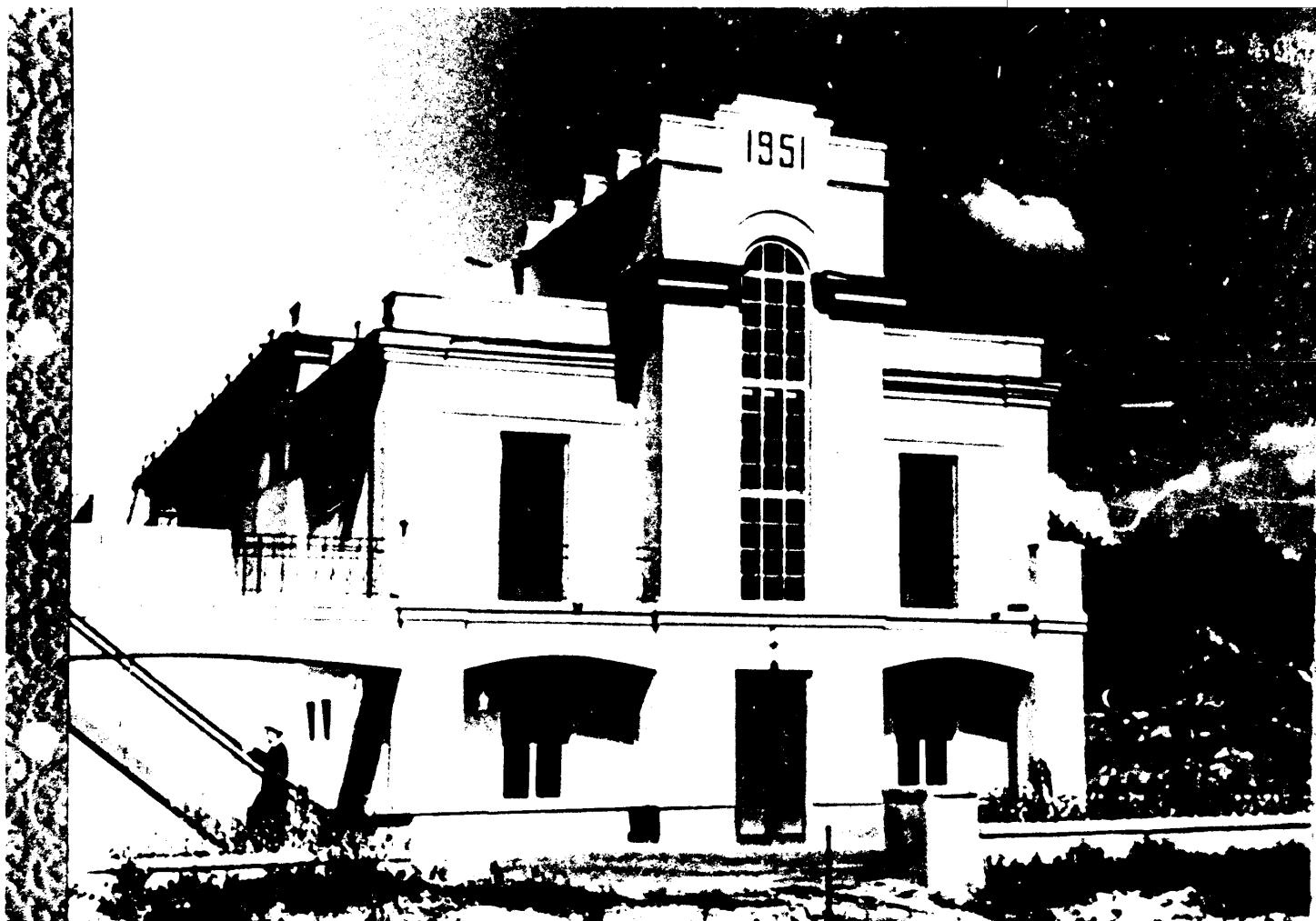
Здание Стеблевской гидроэлектростанции
