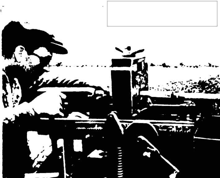
Опрессовка провода в полевых условиях
