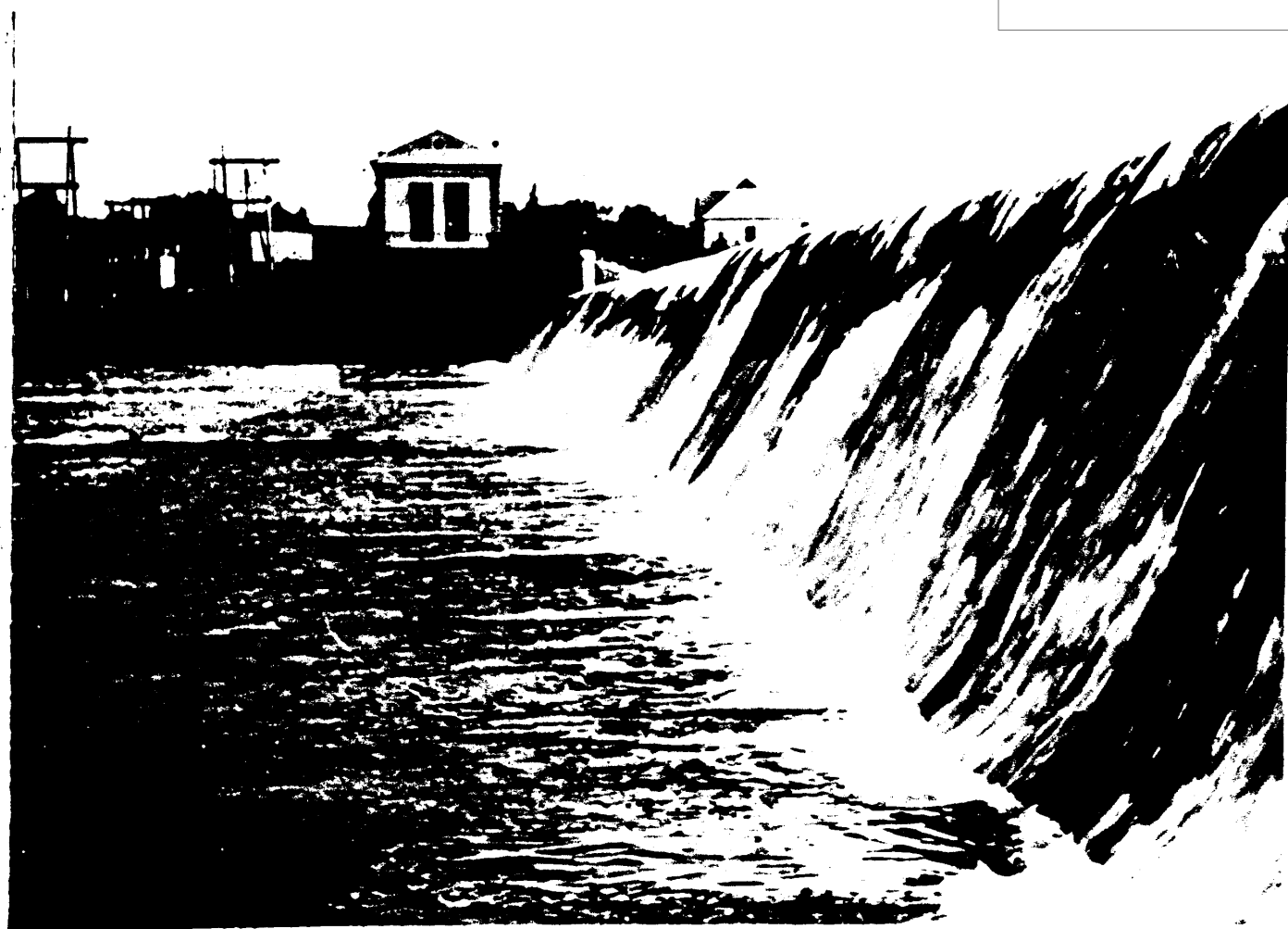
Водоливная плотина Дыбенской гидроэлектростанции
