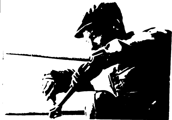
Установка распорок между проводами
