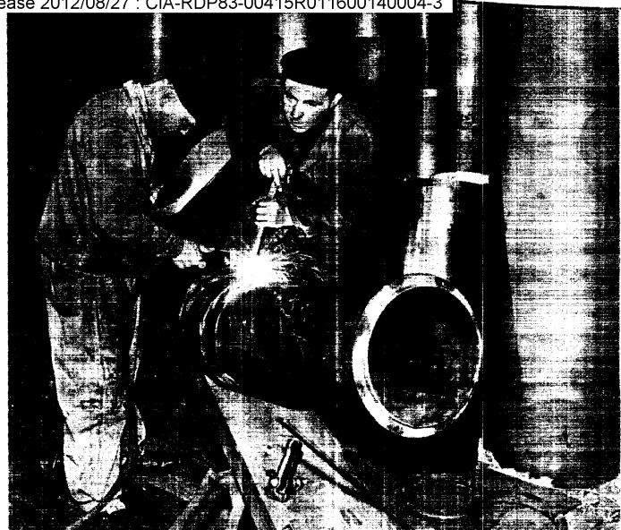
Vedoucí čety sověť Jaroslav Hošťálek a Jan Čiecký z národního podniku Janka při svařování odsávacího potrubí pro Kunčice.
