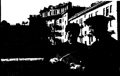
Los albañiles Vasili Koroliov y Piotr Orlov (a la izquierda), ambos laureados con el Premio Stalin, en las obras de una nueva casa que se construye en Moscú.
