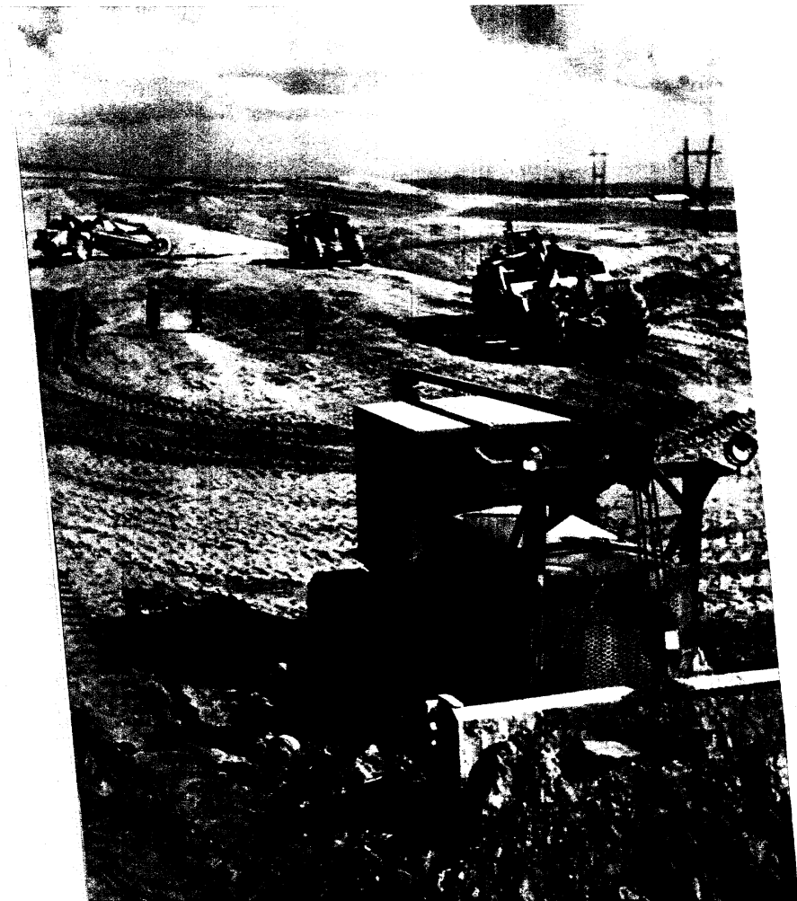
En las obras de Samgori hay muchas máquinas. Hacen los trabajos más pesados. En el primer plano de la fotografía, un poderoso «buldozer» soviético. Detrás de él avanzan los «scrapers» de autopropulsión, dedicados a levantar la presa del Sur.
