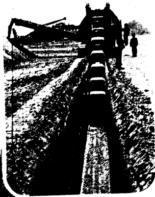
Una excavadora mecánica de zanjas abre una trinchera para el tendido de una nueva conducción central de aguas (a la izquierda).
