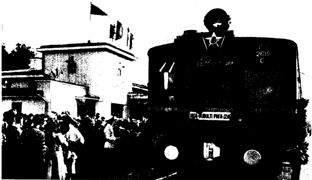
En Letonia se ha inaugurado el tráfico en una nueva línea férrea electrificada que comunica Riga, capital de la República, con la estación de Dubulti, en el litoral. En la foto: Llegada del primer tren eléctrico a la estación del balneario de Bulduri.
