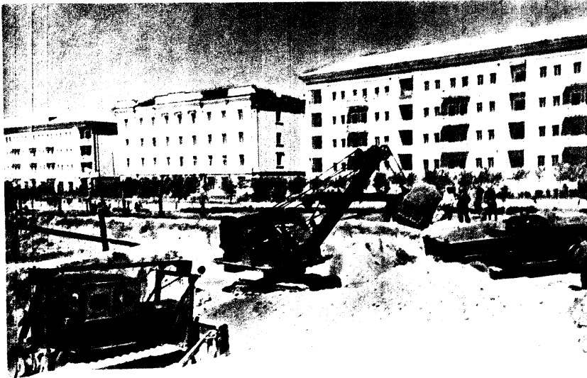
Este año se construye en Karaganda nuevas grandes casas de vivienda con destino a los mineros. En la foto: Trabajos de excavación en las obras.
