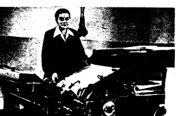
Ułożone w specjalnej formie czołki umieszczane są na maszynie drukarskiej. Kobieta porusza je za pomocą specjalnych narzędzi, które automatycznie odwołują się do formy. Maszyna ta nosi nazwę „płaski”. Drukarka ona jest ostatnia.
