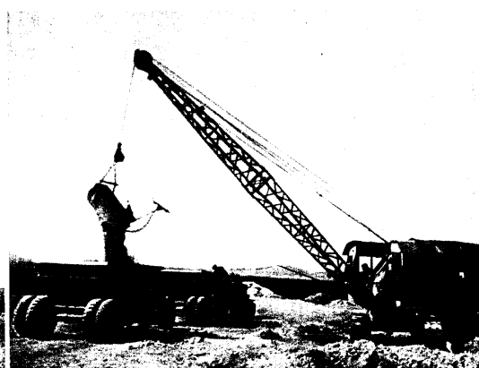
Una máquina excavadora en funcionamiento. Cada vez, su «mano» se lleva una tonelada de tierra. La tierra es cargada en un remolque, tirado por tractor, que puede contener veinte toneladas, es decir, tanto como un vagón de mercancías.
