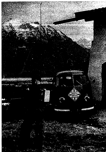
Bild 8: Fahrbare Relaisstation für Entörungsdienste an Hochspannungs-Überlandleitungen, ein-gesetzt bei Wallgau (vgl. Bild 9)
