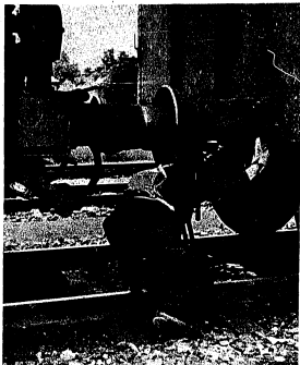
Bild 4: Der mit Teleport IV ausgerüstete Rangierer beim Kuppeln; die auf dem Rücken getragene Stromversorgung des Gerätes ist so geformt, daß sie beim Rangieren nicht hinderlich ist.
