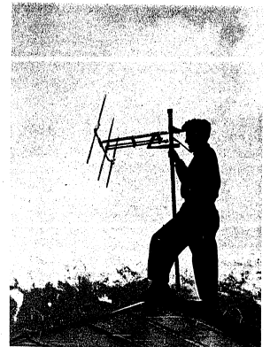
Bild 10: Richtantenne einer ortsfesten Funkstelle auf einer Seilbahnstation (der Mann neben d. Antenne ermöglicht den Größenvergleich)
