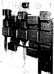
Verteiler für Klimaanlage in einer Textilfabrik.
