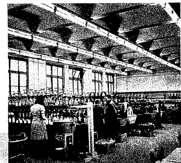
Der gleiche Arbeitsraum nach dem Einbau der Leuchtstofflampen
