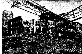
Veturin ja vaunukorjauksia hävityksen jälkeen.
