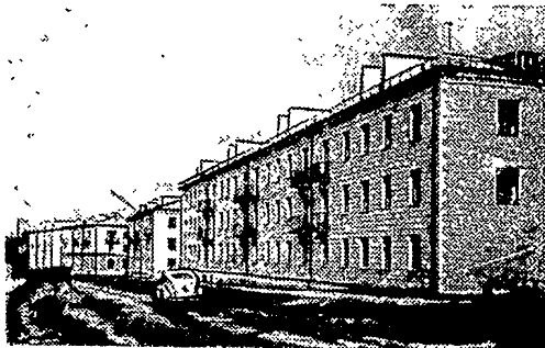
Рис. 2. Жилой дом, обшпательный силикатными блоками
