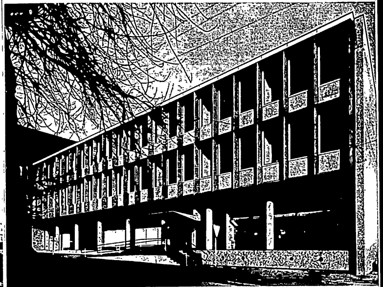
Bild 7 Forschungsinstitut für Rationalisierung an der Technischen Hochschule Aachen
