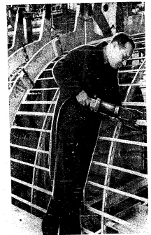
Фиг. 6. Работа пневморычажным прессом.
