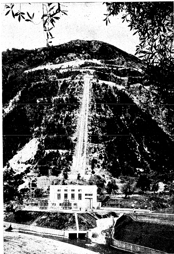
ΔΗΜΟΣΙΑ ΕΠΙΧΕΙΡΗΣΙΣ ΗΛΕΚΤΡΙΣΜΟΥ Ὑδροηλεκτρικὰ ἔργα Λιάδων. Ὑδροηλεκτρικὸν ἔργαστάσιον ἰσχύος 50.000 Χ.Β. Τὸ μεγαλύτερον ὑδροηλεκτρικὸν ἔργον τῆς Ἑλλάδος.
