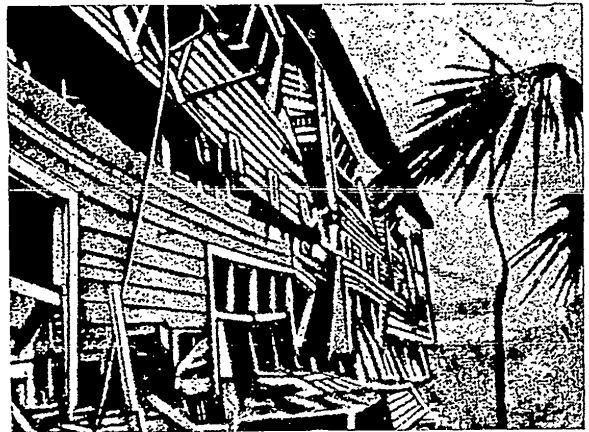
Рис. 18. Паянтова постройка след атомен взрив на разстояние 2500 м от мястото на взрива
