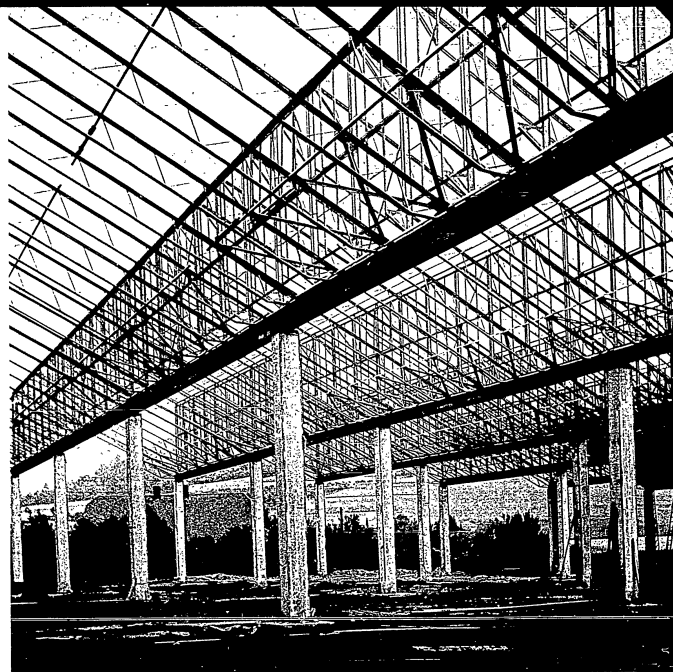
Una fábrica construida de acero de un „Jalt“
