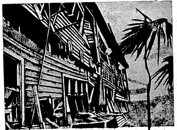
Рис. 18. Паянтова постройка след атомен взрив на разстояние 2500 м от мястото на взрива
