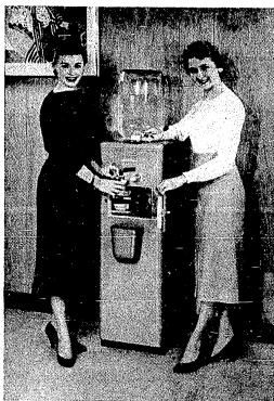
1. Automat na prípravu teplých a studených nápojov máva aj chladiaci prístroj na uschovu potravín a výrobu ľadových kociek. Automat má vlastný zásobník vody a je nezávislý od vodovodnej siete
