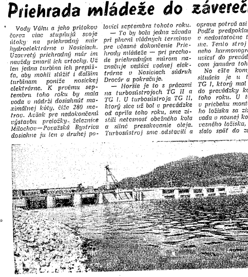
Na snímke celkový pohľad na priehradu máru v južného diela v Nosičoch.
