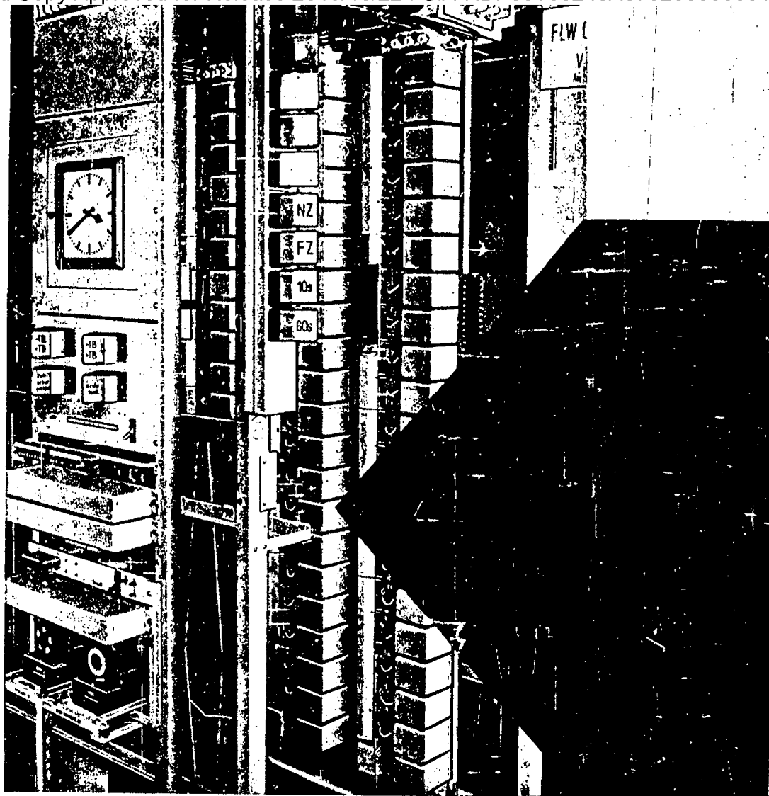
Bild 11 Zeitberggestell mit Gruppen-Signalrahmen und Signallampenrahmen
