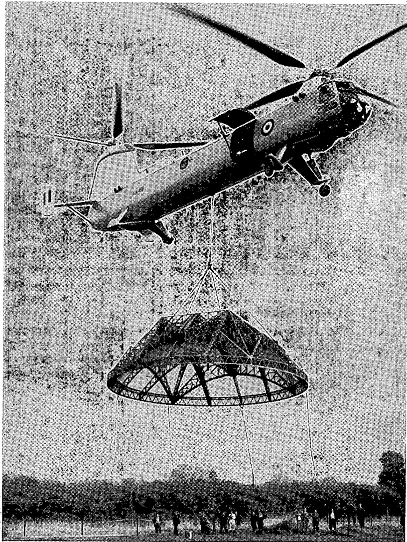
Abb. 35 Hubschrauber beim Transport einer großen Stahlgitterkonstruktion
