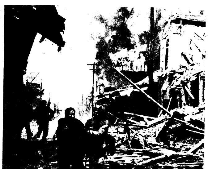
解放战争时期，人民解放军解放太原战斗时国民党反动派放火屠城，企图顽抗，攻城部队战士一面搜索残敌，一面抢救群众。
