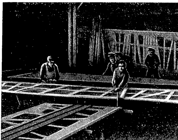
Рис. 89. Шаблоны для разметки листов
