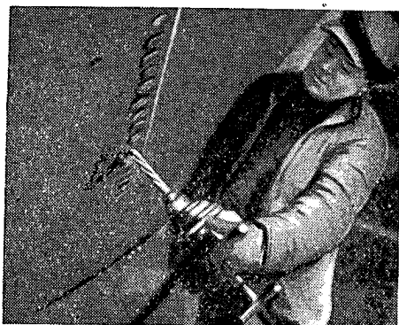
Рис. 21. Сверление отверстий пневматической сверлильной машинкой
