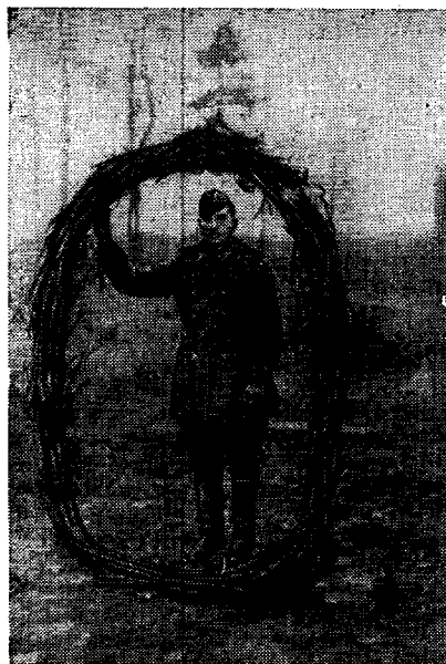
Рис. 4. Фашинная рама с круглым сечением стенок.
