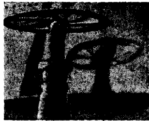
Фиг. 48. Светлинното излъчване се разпространява праволинейно. Боята на газголдера е изгоряла, а местата, засенчени от вентила, са останали невредими
