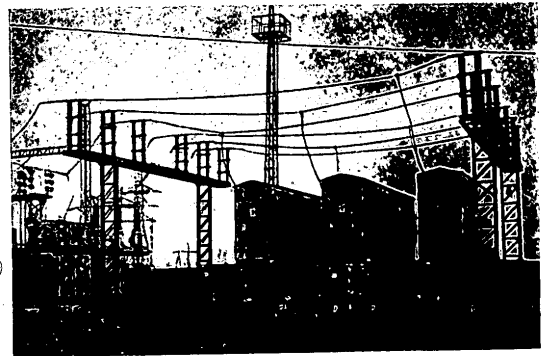
Фиг. 15. Установка продольной компенсации 110 кв.
