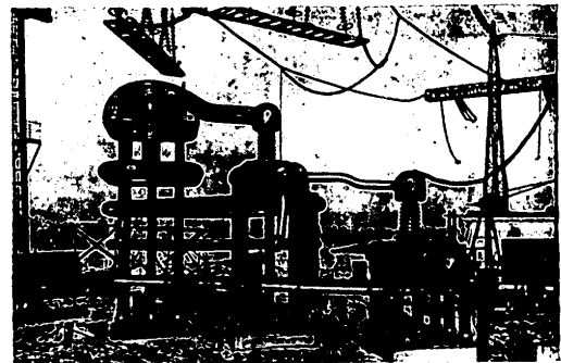
Фиг. 10. Каскад испытательных трансформаторов на напряжение 2,25 млн. в.
