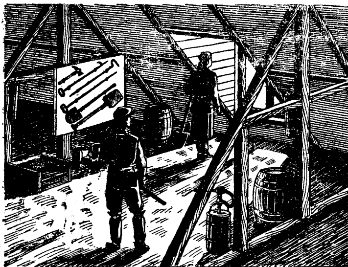
Рис. 31. Пожарный пост на чердаке
