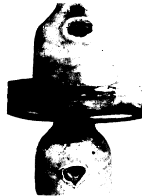
Bild 12 Durchgeschlagene Kappenisolatoren nach Lichtbogeneinwirkung.
