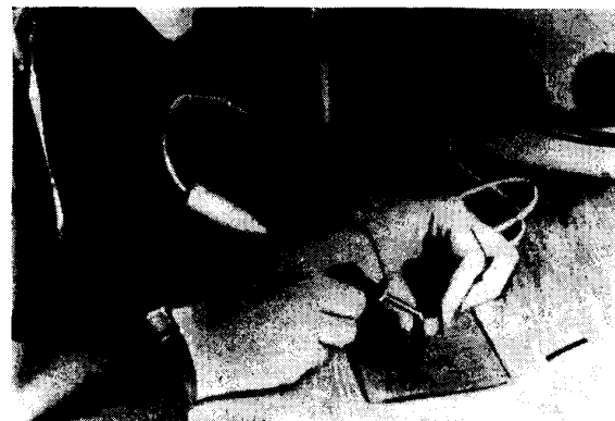
Bild 3 b Befugung mittels Griffelvibrator
