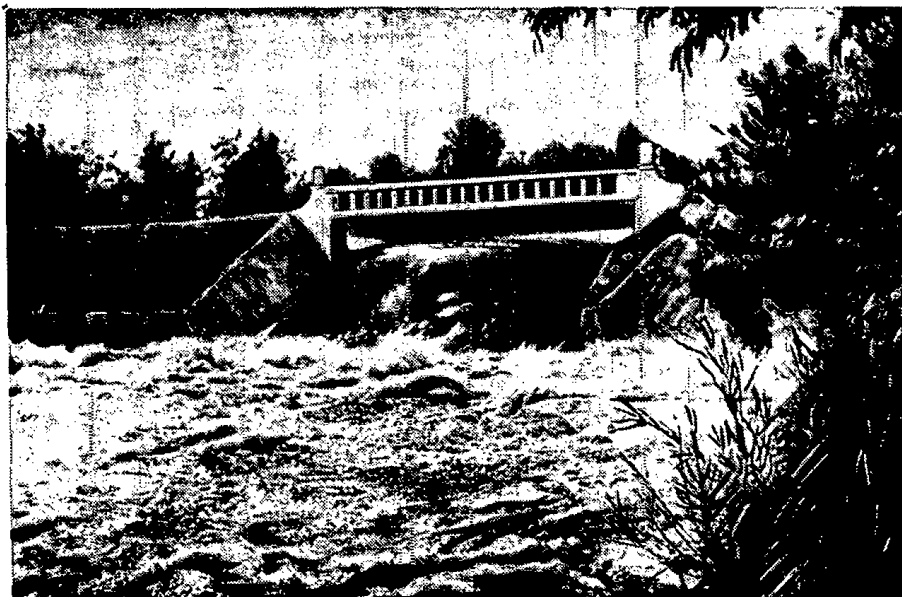
Рис.13. Перепад на Большом Ферганском канале. Fig.13. Drop Structure on the Great Fergana Canal.
