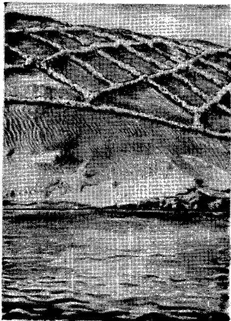
Рис.44. Крепление барханных песков по трассе Кара-Кумского канала.
