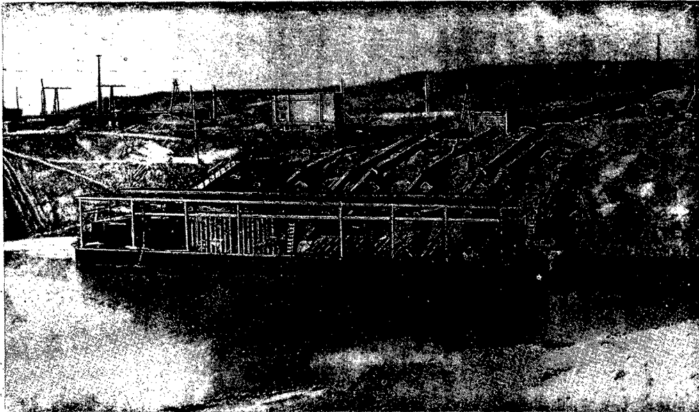
Рис.37. Плавучая насосная станция. Самгарская оросительная система. Fig.37. Floating Pumping Station. Samgar Irrigation System.
