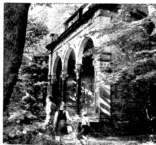
Vergessen auf dem Böttcherberg in Zehlendorf: Teufhaus aus „besseren Zeiten“, offenbar dem Verfall preisgegeben. Die schönen Mosaiken im Inneren sind zerstört. Wer wird das reizvolle Bauwerk erhalten? Foto: Walter
