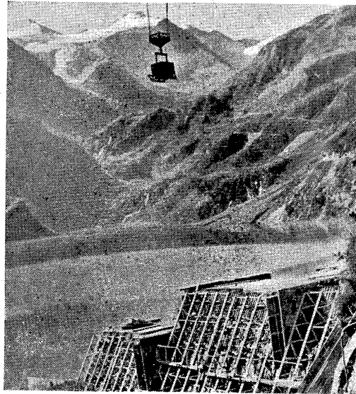
Bau der riesigen Staumauer auf dem Moserboden über Kaprun
