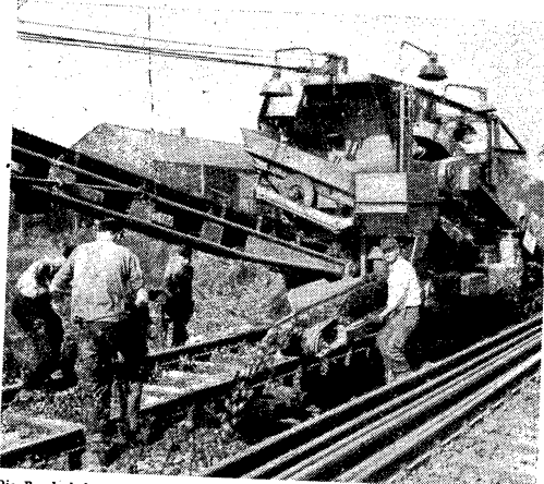
Die Bundesbahn schüttelt ihre „Betten“. Seit zwei Jahren arbeitet diese Maschine auf den weitausläufigen Strecken, um den Gleisunterbau neu aufzuschütteln und zu stellen. Sie schafft 1000 Meter am Tage. Foto: AP
