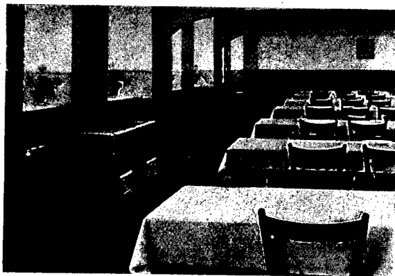
Schilde Raum-Lufterhitzer in einem Speisesaal
