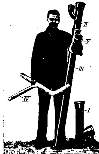
Bild 4: Fertigteile für die Abflußleitung gemäß Bild 3
