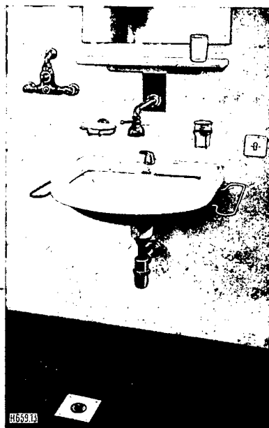
Bild 13: Ansicht eines Handwaschbeckens mit automatischem Warmwasserventil und Fußbetätigung durch Fußventil, Ausführung Kugler S. A., Genf
