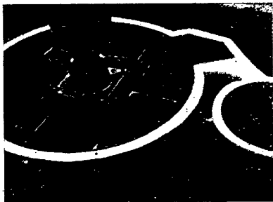
Bild 2. Pista-Belüfter mit Gußeisenspänen im Betrieb.
