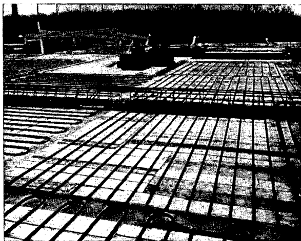
Montage einer Decken-Strahlungsheizung
