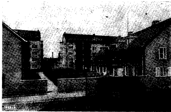
Bild 9. Neues Wohnviertel in der Altstadt von Hannover an der Kreuzkirche.
