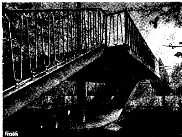
Bild 7. Vorgespannte Stahlbeton-Fußgängerbrücke auf der Bundesgartenschau.
