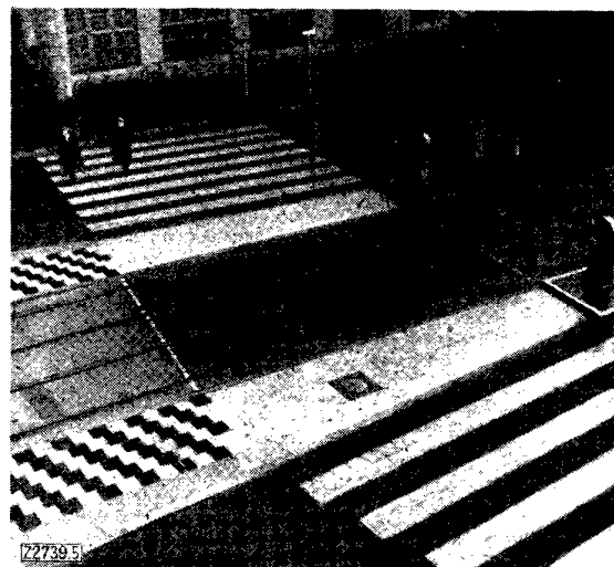
Bild 5. Fußwegübergang am Ägidienorplatz. Optische Kennzeichnung nach holländischem Muster.
