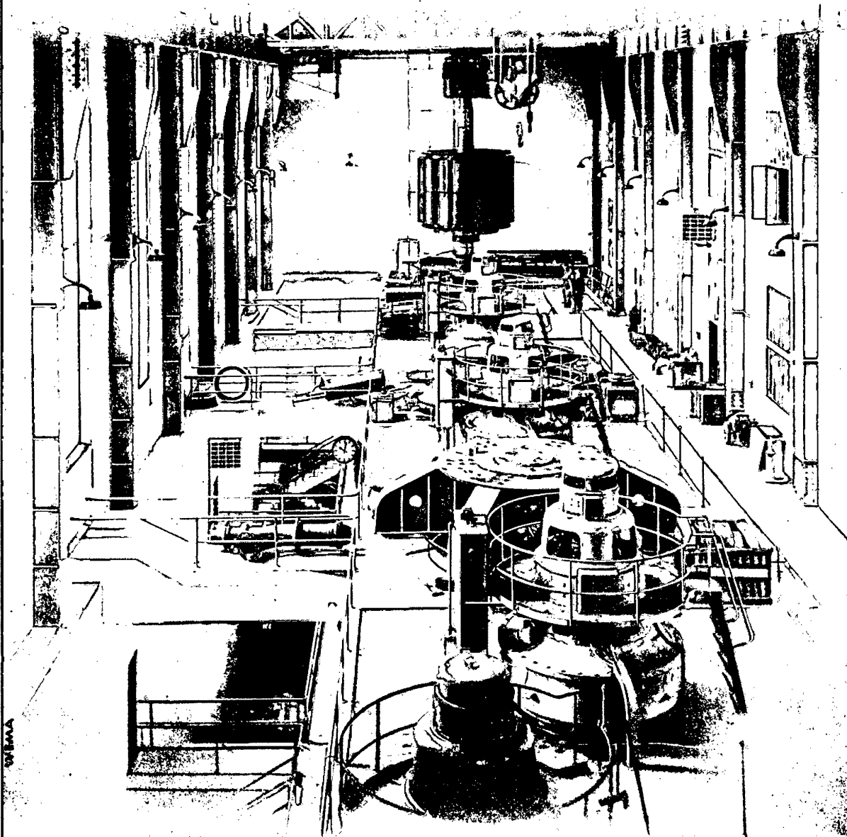
4 Generatoren je 55000/60000 kVA, \cos \varphi = 0,8 , 10 500 Volt, 333,3 U/min, 50 Hz. Anlage Witznau der Schluchseewerk-AG., Freiburg im Breisgau
