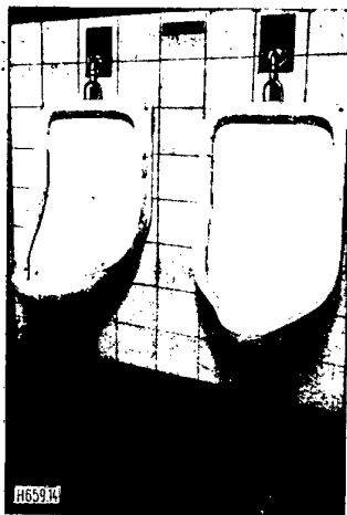
Bild 12: Urinalbecken mit Spüleinrichtung und Betätigung durch Fußbodenventil, Ausführung Kugler S. A., Genf
