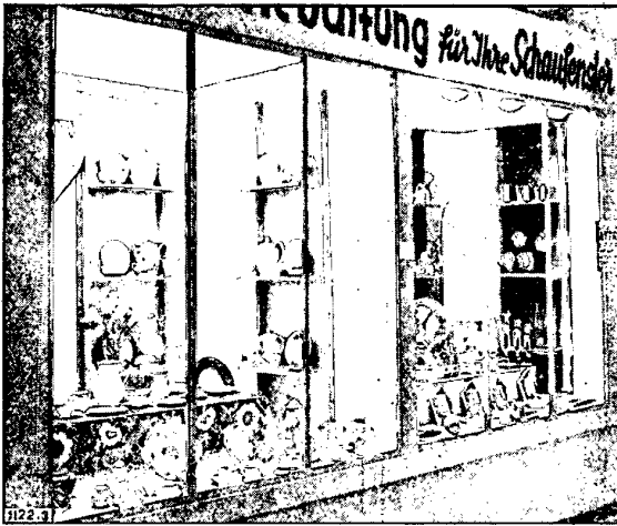
Bild 3: Schaufensterbeleuchtung links mit Leuchtstofflampen, Gesamtleistung 500 W; rechts mit Glühlampen, Gesamtleistung 900 W
