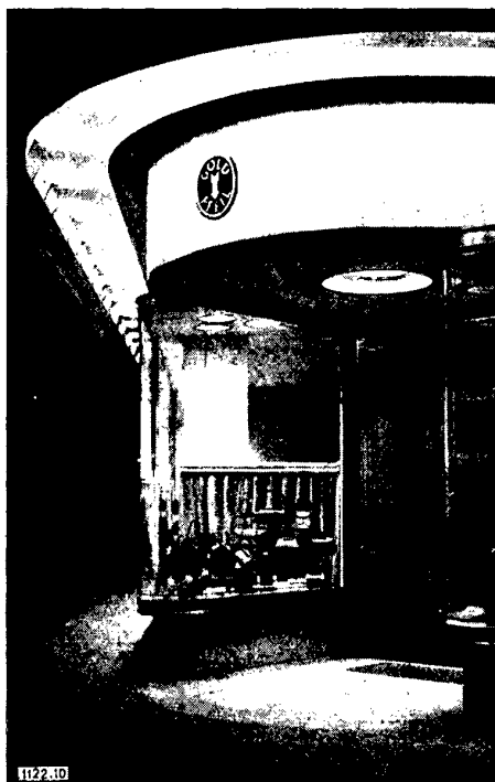
Bild 10: Eckschaufenster nur mit Spiegelreflektoren, tief in die Decke eingezogen
