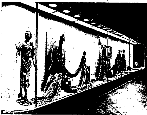
Bild 6: Diffuse „Oberlichter“ (Rasterleuchten mit Leuchtstofflampen); verstärkter Zusatz aus Spiegelreflektoren
