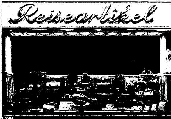
Bild 1: Tiefstrahlerbatterie schafft hohe Beleuchtungsstärke
