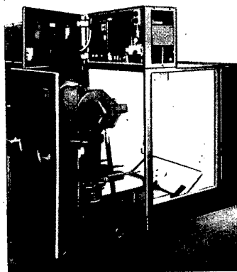
Bild 3 Schaltanlagengruppe mit geschotteten Schalteinheiten, Schalter ausgefahren
