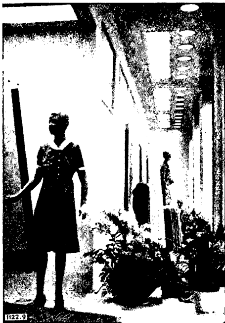
Bild 9: Eckschaufenster mit blendungsfreien, kombinierten Rasterleuchten in der Decke
