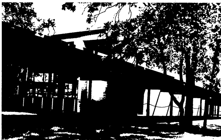
F. H. Black Jr. High—Houston, Texas Mech. Cont.: Robischung-Kiesling Insulation Cont.: Precision Supply Co.
